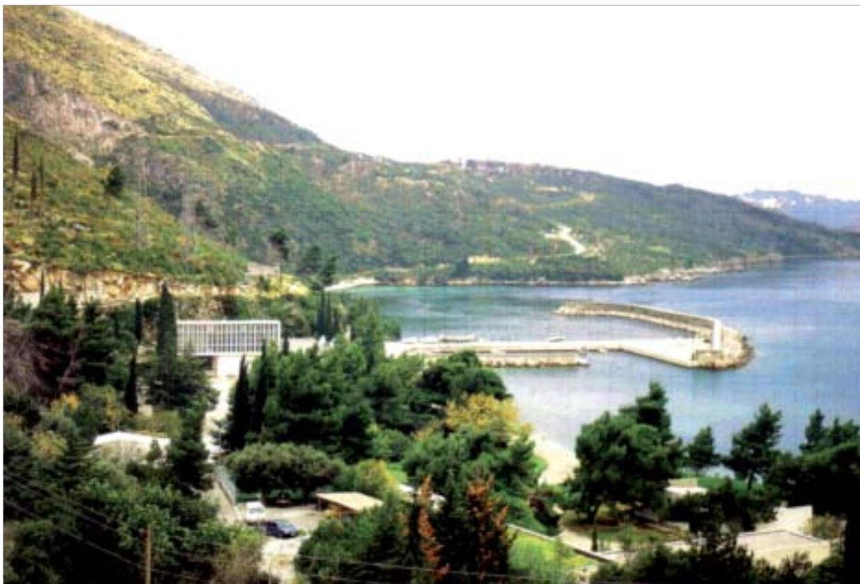
Izlazna građevina HE Dubrovnik u Župskom zaljevu
